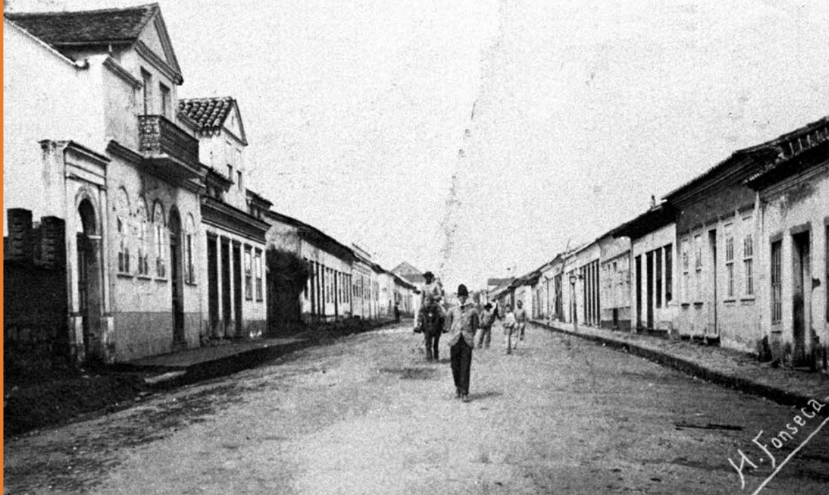
Castro. Vista da Rua Doutor José Xavier.
