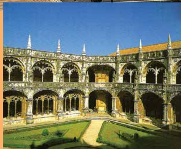
Claustro do Mosteiro.
